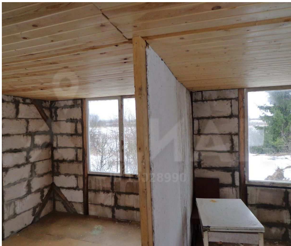
Вид стен дома из газобетонных блоков, встроенных в каркас.
